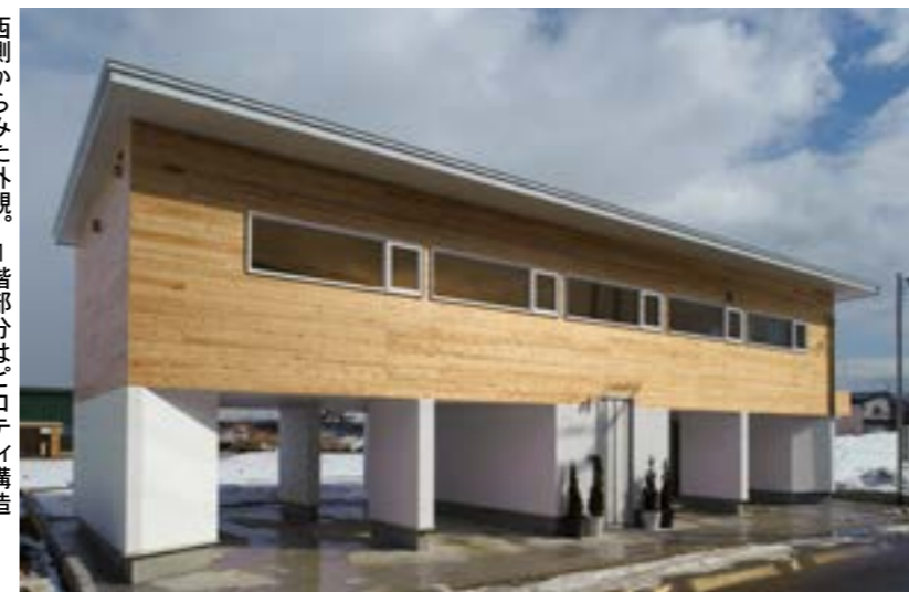
西側からみた外観。1階部分は、ピロティ構造
