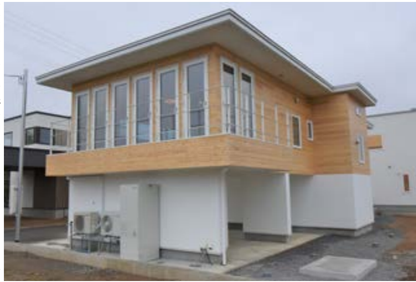
南東側からみた外観。南側屋根の軒は1階出しており、夏は日射を遮り、冬は大開口の窓が日射を導く。また、ベランダ下の庇が1階部分に設けられた雪室への日射を遮るように配慮されている
